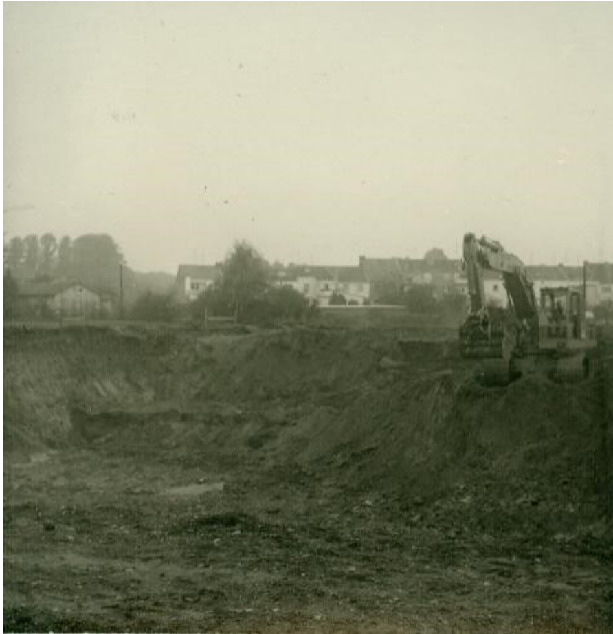
Abb. 2.: Erste Erdarbeiten auf dem Gelände.
