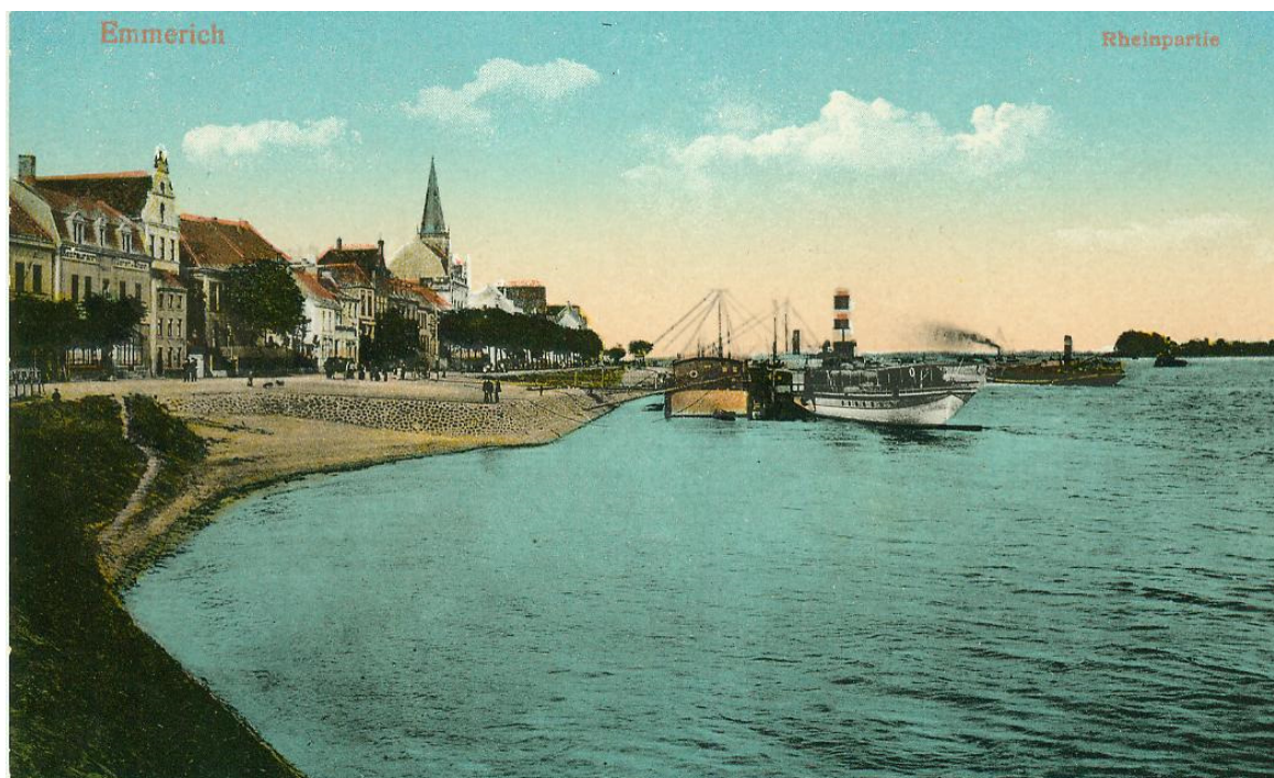
Abb.1.: Anlegestelle „Stadt Emmerich“ ca. 1920.
