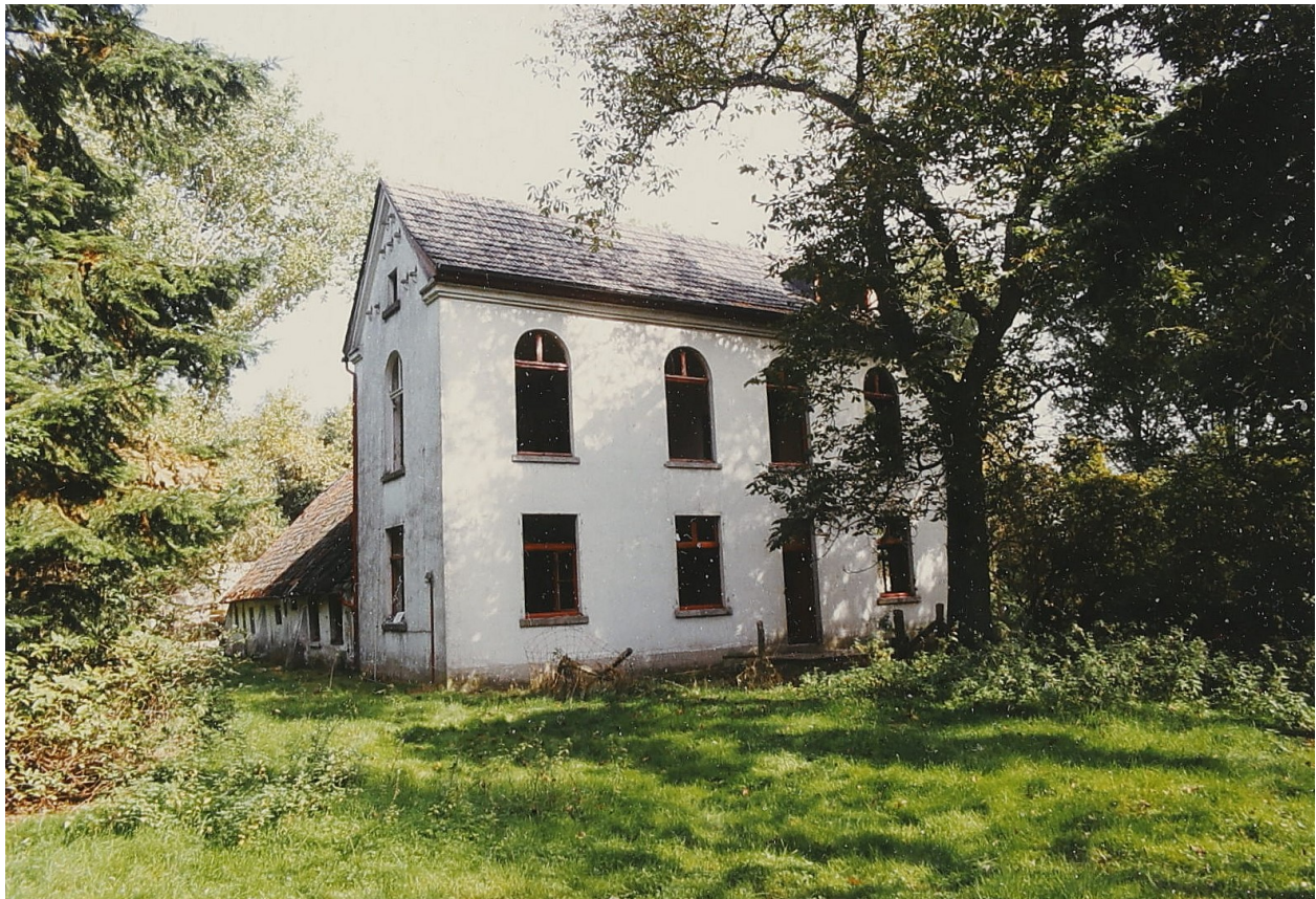
Abb. 5.: Duvendahl kurz vor dem Abriss.
