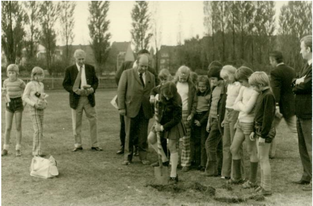
Abb. 1.: Der erste Spatenstich.
