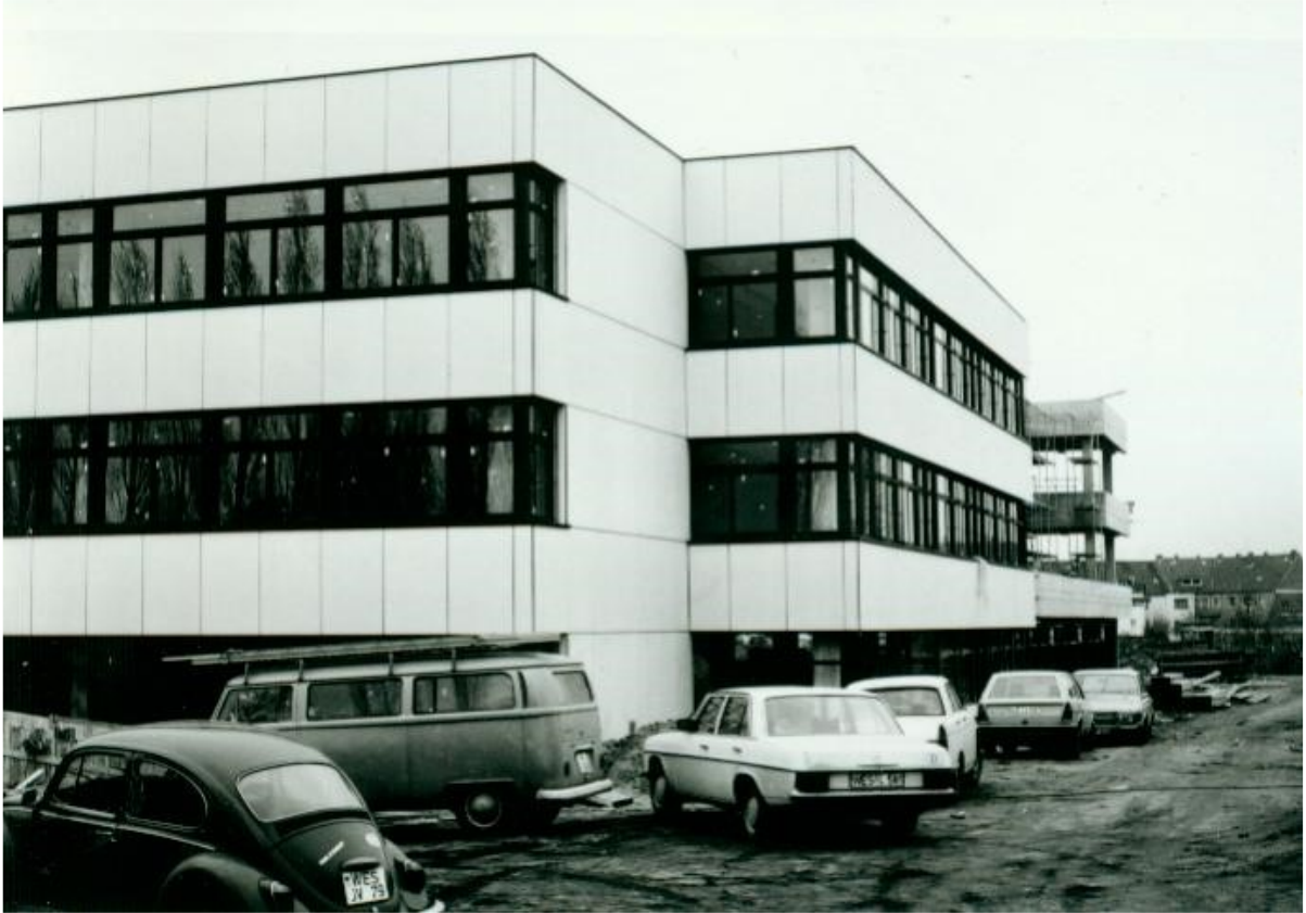
Abb. 6.: Neubau des Schulzentrums, 1975.
