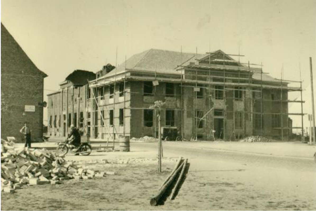
Abb. 4.: Postamt Wiederaufbau, ca. 1952.
