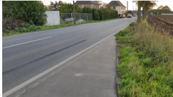
Abb. 4.2.6-7 Netzlücke, Netterdensche Straße
