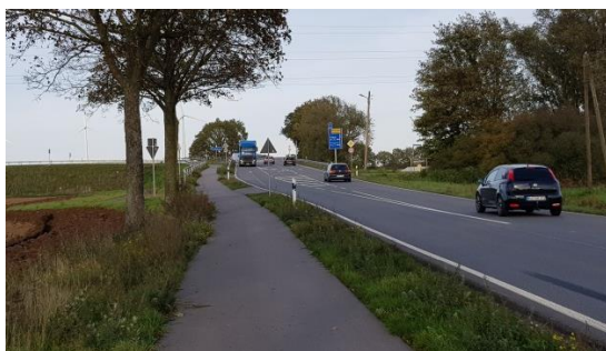
Abb. 4.2.6-3 Gemeinsamer Geh- und Radweg (benutzungspflichtig), Netterdensche Straße
